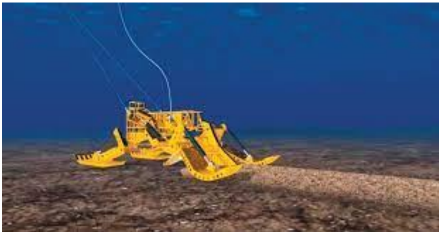
Ensuillage câbles (fonds meubles)
