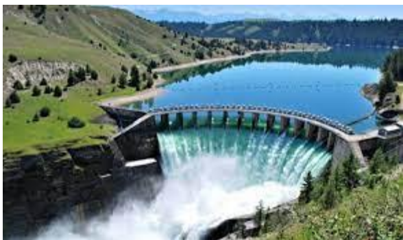
Barrage hydraulique en montagne (Alpes, Pyrénées ...)
