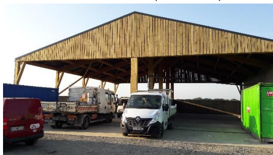
Aire de stockage (17/09/2020)
