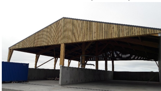
Aire de stockage (10/09/2020)
