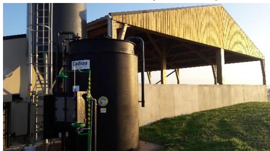
Aire de stockage (26/11/2020)
